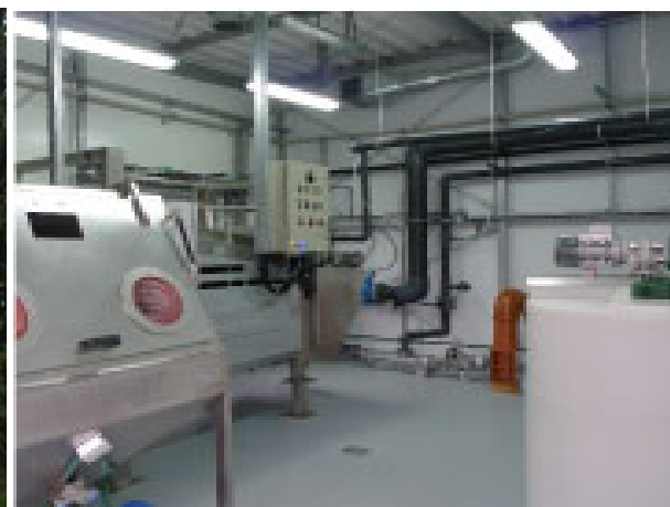
Rys. 54. Oczyszczalnia ścieków w Łaskarzewie źródło: www.ppeko.com.pl
