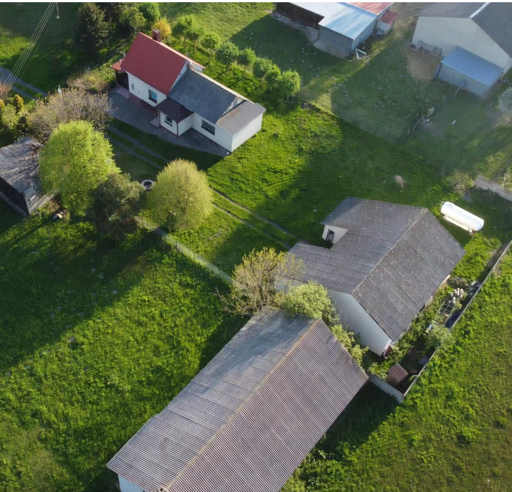
Fot. 1. Wykorzystanie wyrobów azbestowych jako pokrycia dachowe
